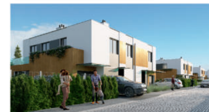
Widok budynku od strony osiedla
