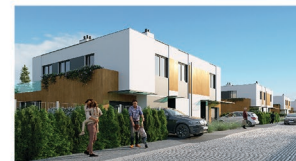
Widok budynku od strony ulicy
